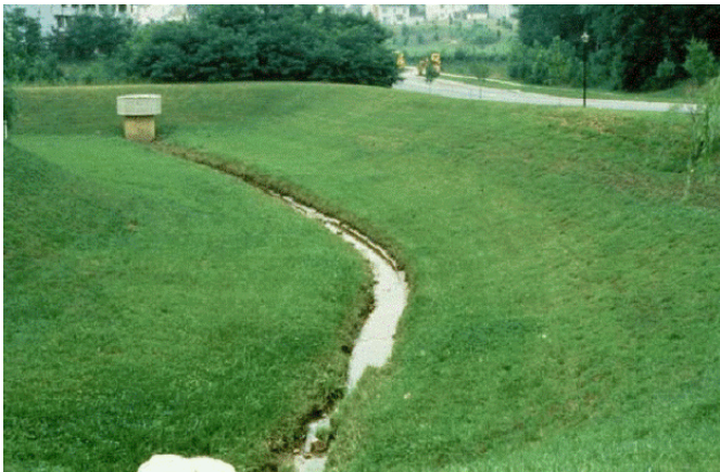
Figure 5.03.2 – Dry Detention Pond ( www.dhn.iihr.uiowa.edu )
