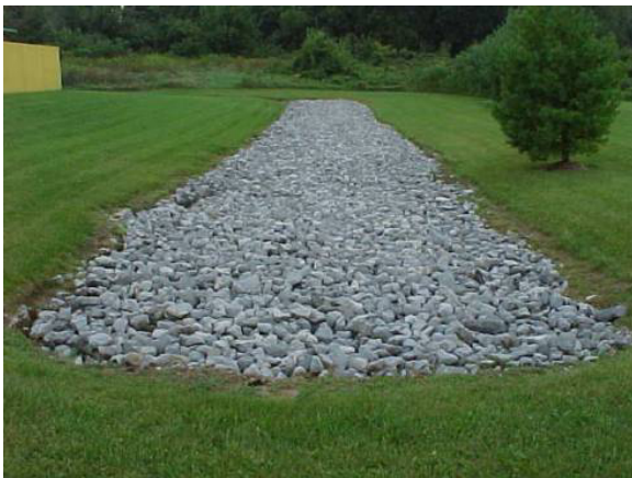
5.01.5 – Infiltration Trench ( www.washco-md.net )
